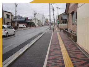
歩道バリアフリー工事
