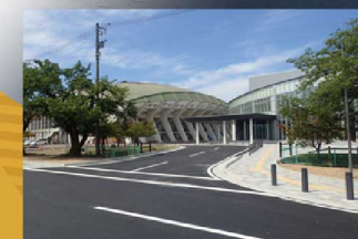
駐車場舗装工事
