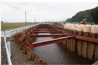
北陸新幹線 排水路移設等工事
