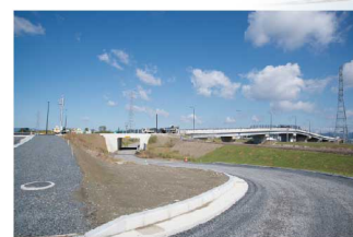
道路改良工事
